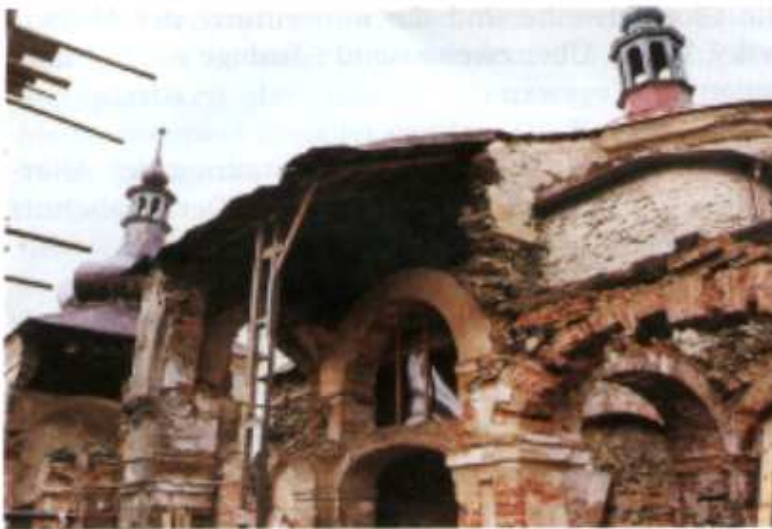
Eingang zur Hl. Geist Kirche Gewölbe eingestürzt, Seitenkapelle durch Einwirkung von Sprengstoff zerstört.
