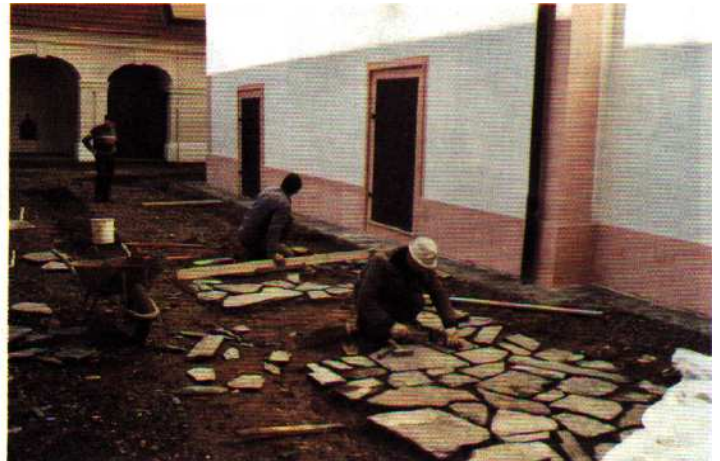
15.11.01: Verlegen von Schieferplatten vom Eingang in das Areal zur Wallfahrtskirche (Jelinek und Mitarbeiter)
