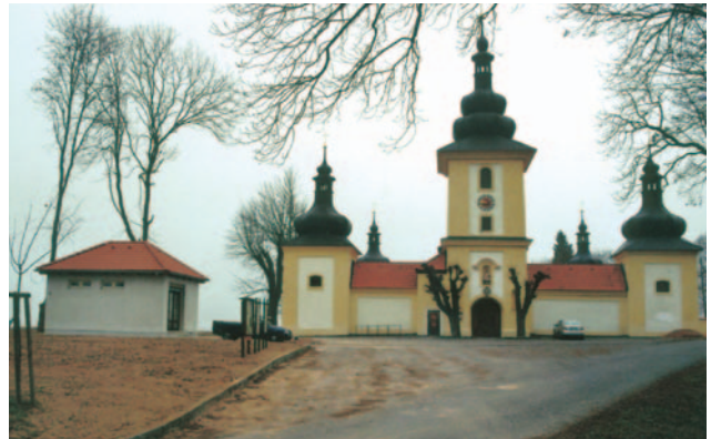
links im Bild die Toilette
