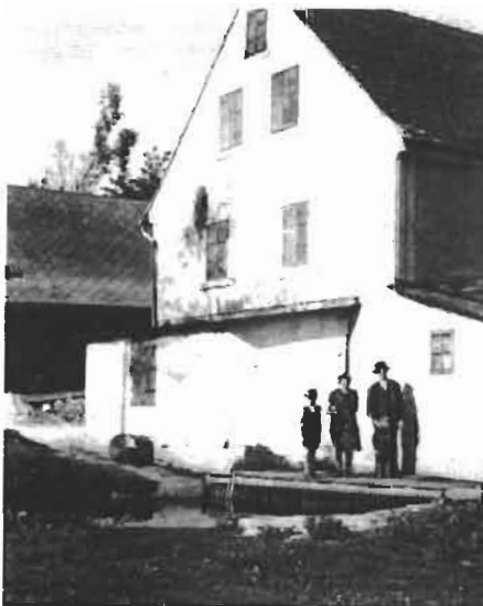
Die Mühle in Fischern. In Bildmitte ist deutlich erkennbar der Zufluß der angestauten Eger durch den Rechen in die Radstube. Die um 1940 entstandene Aufnahme zeigt vorne die Familie des Mühlbesitzers Oswald Rupprecht mit den Söhnen Erwin und Otto.
