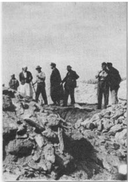
Der steinige Untergrund erschwerte und verzögerte den Fortgang der Arbeiten
