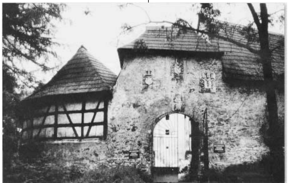
Schloß Seeberg ehemals gotisches Vortor, darüber herrschaftliche Wappen, Anfang 20. Jh.; Durchblick zum Hauptschloß; die Baulichketen wurden 1987 bis 1990 renoviert.
