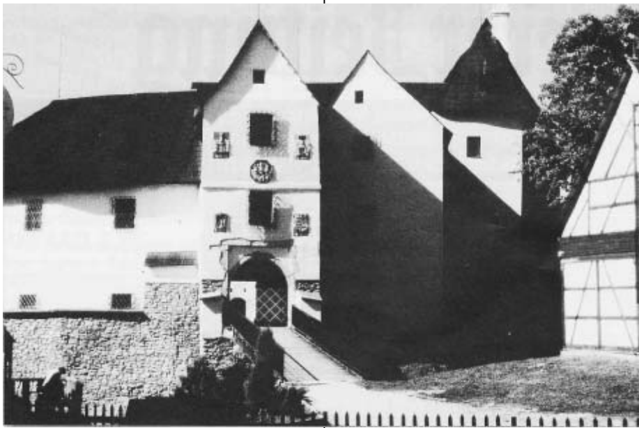
Schloß Seeberg; auf romanischen Ursprung zurückgehendes Hauptschloß; früher über eine Zugbrücke über den Halsgraben erreichbaren Zugang mit gotischem Portal, darüber Herrschaftswappen aus der Zeit der Renovierung Anfang des 20. Jahrhunderts, rechts, diesseits des Grabens, Museum ländlicher Kultur des Egerlandes.
