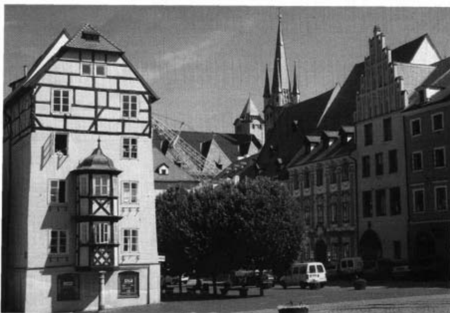
Eger. Die Türme der Stadtpfarrkirche während der Renovierung ihrer Dächer. Der südliche Turm trägt schon die neue (und alte) neugotische Spitze mit Schieferdeckung, während der Nordturm noch das bisherige „Behelfsdach“ aus der Nachkriegszeit trägt. (Foto Stadt Eger/Cheb)
